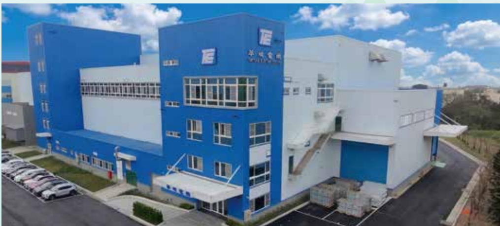
觀音電力二廠落成啟用， 增強整體接單與交付能力。
