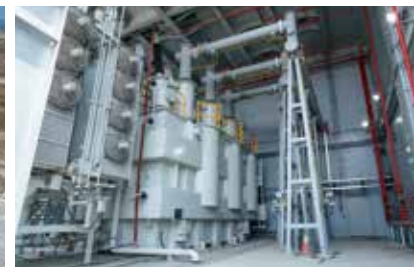
華城電機交付兩具 345kV 380MVA 超高壓變壓器至大彰化離岸風場陸域變電站，以最高規格電力技術支持台灣能源轉型。
